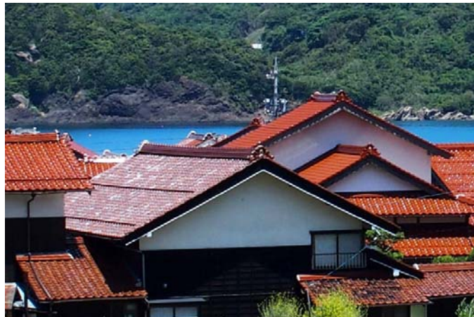
海の色と対比になり寒さや塩害にも強い石州赤瓦。(鹿島町)
