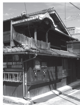
庇上にはこの地方独特の屋根神様が鎮座する
