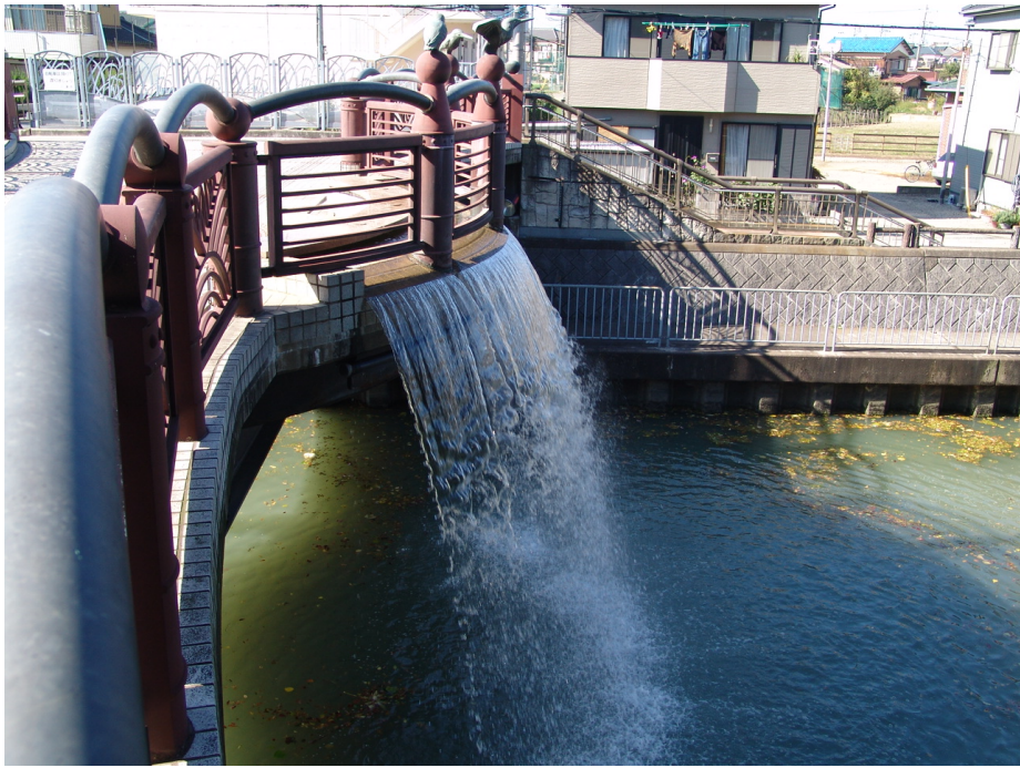
平成泉橋からの浄化水の放水風景
