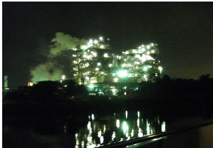
塩浜運河付近の製油所
