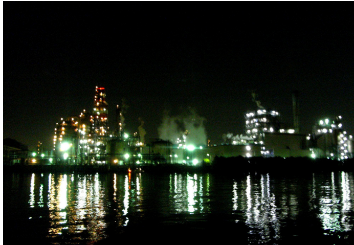
池上運河付近の製油所
