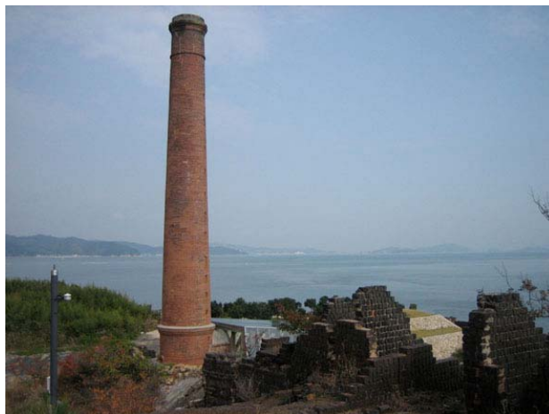
煉瓦づくりの精錬所煙突が犬島のランドマークになっている。
