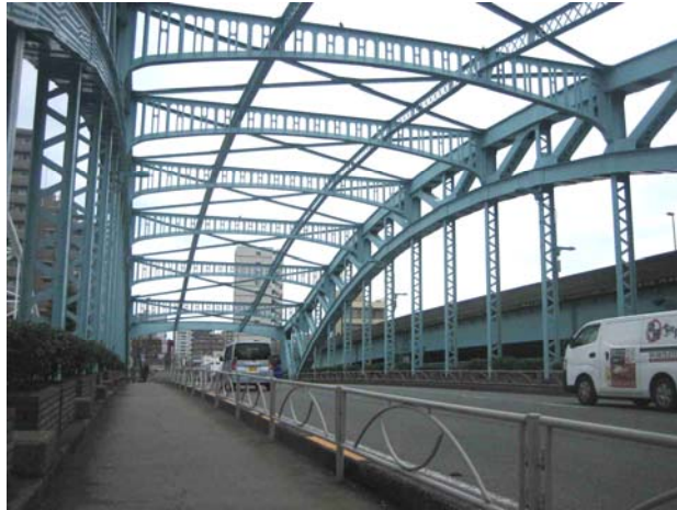
柔らかい鋼鉄アーチのフォルムが歩いていても気持ちよい
