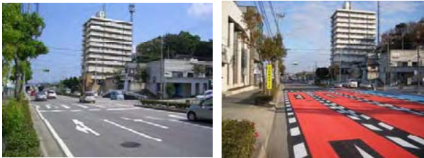
対策前 対策後 写真1 カラー舗装対策前後の状態 (主) 岡崎環状線 竜美台2交差点
