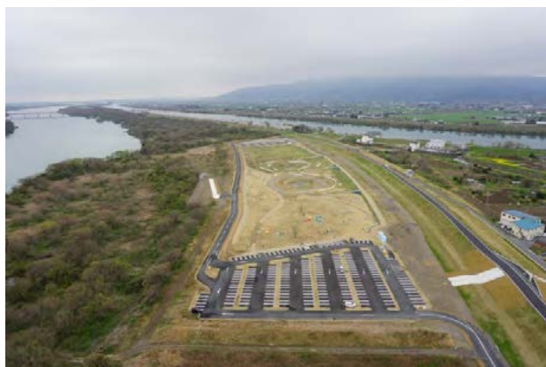
図1 桜堤サブセンター全景
